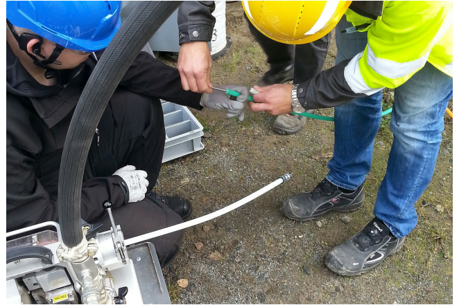
Sondin syöttäminen kuituputkeen ennen putken liittämistä puhalluskoneeseen.
