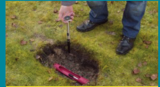
Sondin paikantaminen onnistuu erittäin tarkasti ja sen avulla vältetään laajoilta kaivannoilta.
