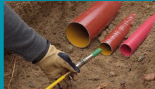
512 Hz sondin voi paikantaa joko muovitai metalliputkissa. 33 kHz sondi on tarkoitettu muoviputkiin.
