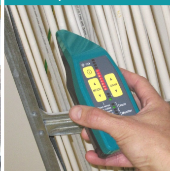
Tunnista arinoilla kulkevat kaapelit luotettavasti
